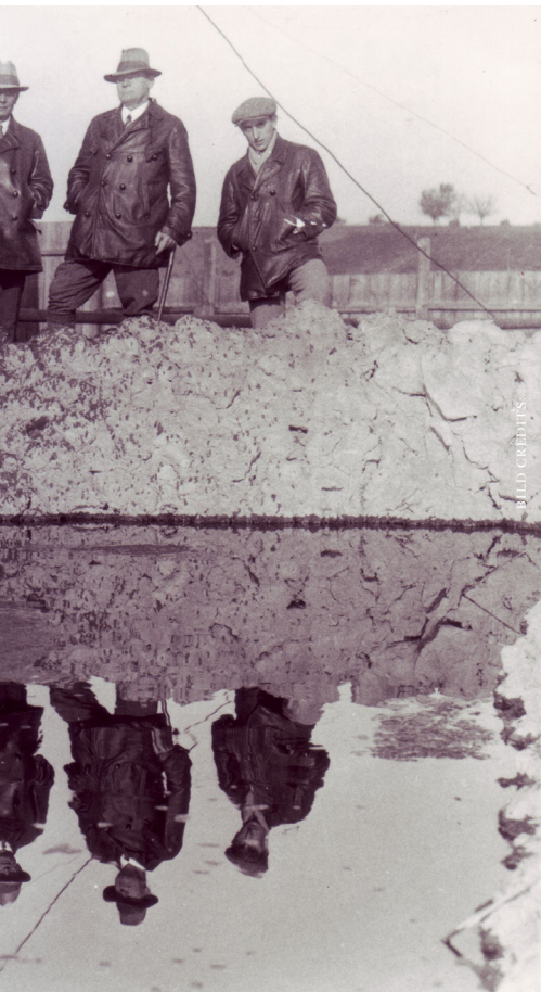
Erdölförderung anno 1932: Weil die Tanks der Förderanlage im niederösterreichischen Zistersdorf nicht für das ausströmende Öl reichten, leiteten die Arbeiter das übrige in provisorisch ausgehobene Gruben. Das Bild zeigt, wie sehr sich der Umgang mit Erdöl in Europa geändert hat.
